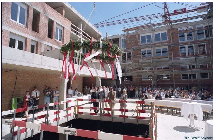
Der Aufbau schritt danach zügig voran.
