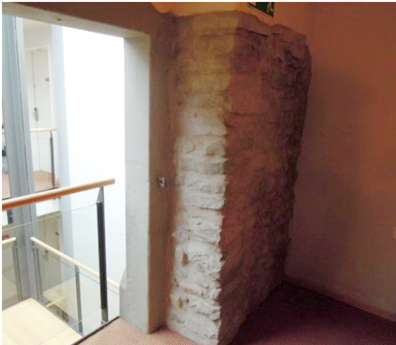
Abb. 7 Die alten Mauern der Ostwand des Spitals aus dem 15. Jahrhundert sind auch im Obergeschoss des Tertianums noch gut zu sehen.
