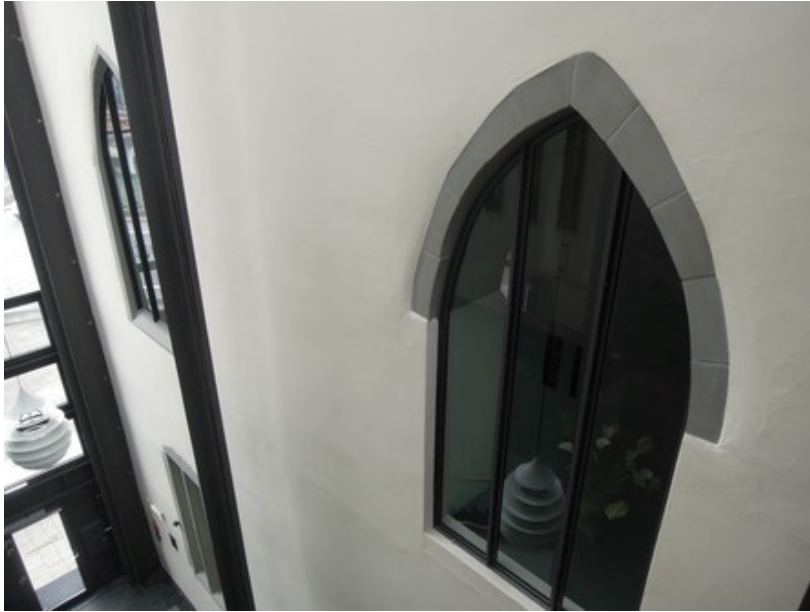
Abb. 6 Die beiden östlichen Spitzbogenfenster sind ebenfalls noch erhalten. Sie gehören auch zur Urologie-Praxis und sind von aussen sichtbar, in der süd-östlichen Aufzughalle des Tertianums.
