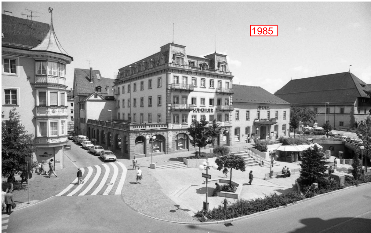
Abb. 9: Blick auf die beiden Gebäude des Südkuriers nach der Untertunnelung von Konzilstrasse und Bahn (Bild aus dem Jahr 1985 )
