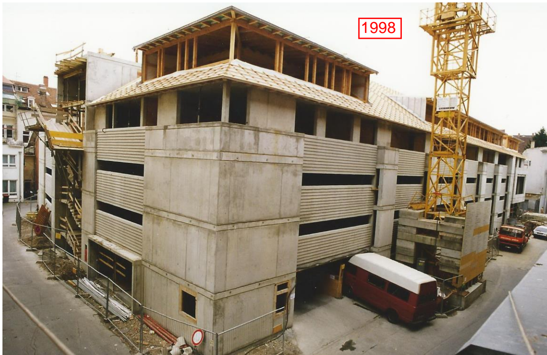
Abb. 11: Hier ein Bild von den Bauarbeiten am Standort „Am Kapuzinerkloster“
