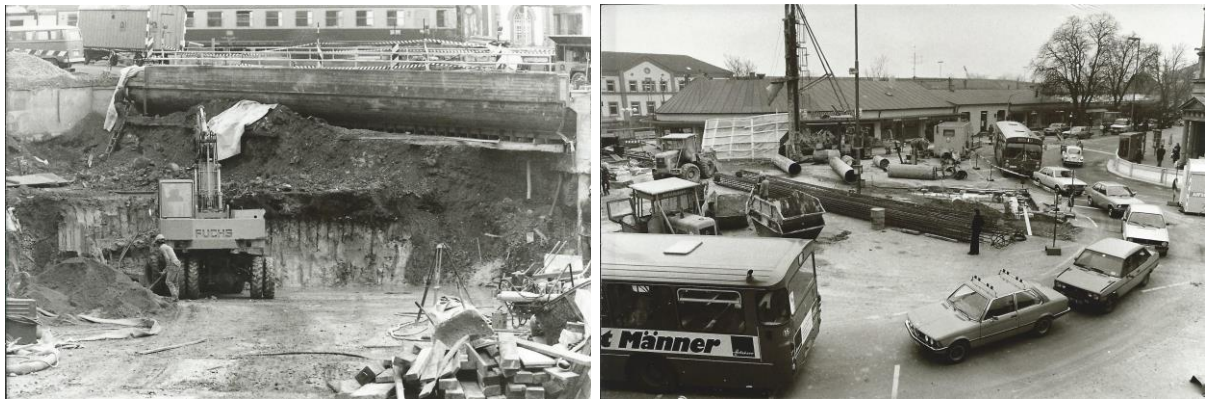
Abb. 8: Die Untertunnelung der Konzilstrasse und der Bahn ( Bild 1980 )
